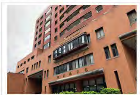
進修推廣學院の建物外観
